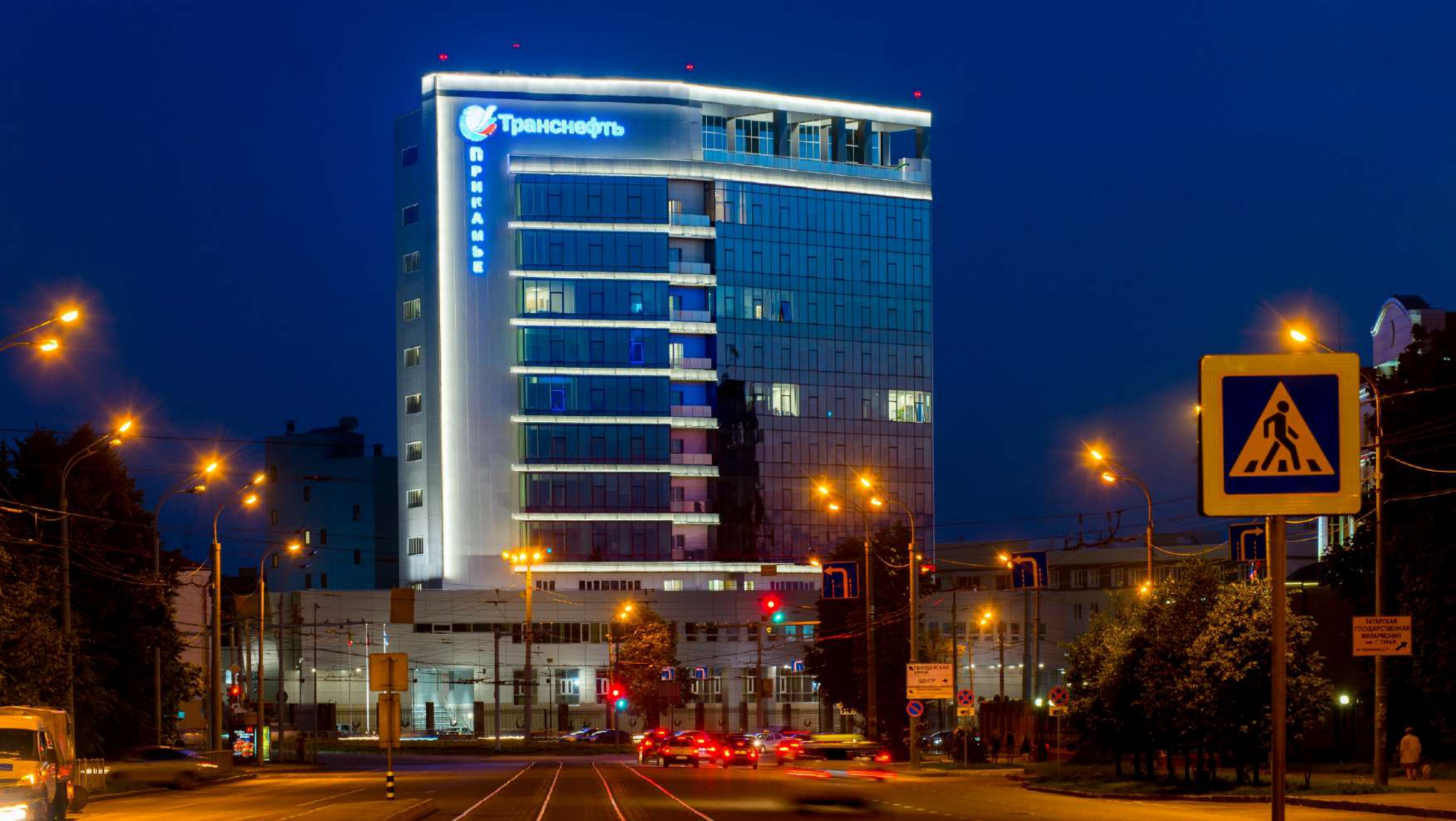
АО «Транснефть-Прикамье», Казань
